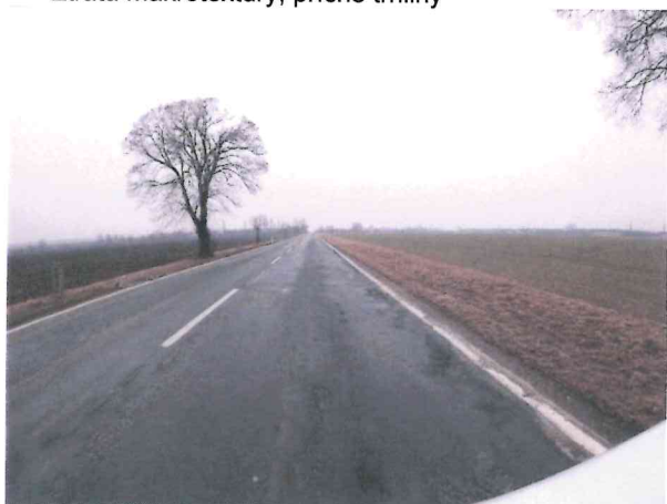
Ztráta makrotext., hloub. koroze, zvýšená nezp. krajnice
