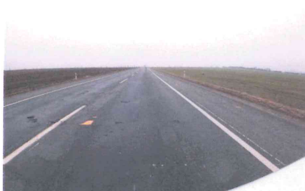
Ztráta makrotextury, výtluky, hloubková koroze
