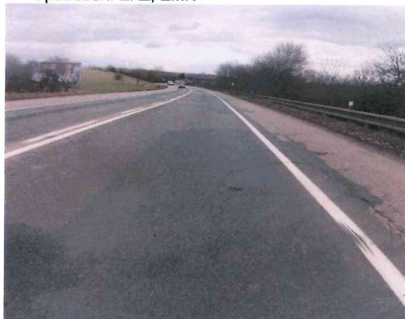
Opotřebení EKZ, EMK, podélné a mozaikové trhliny
