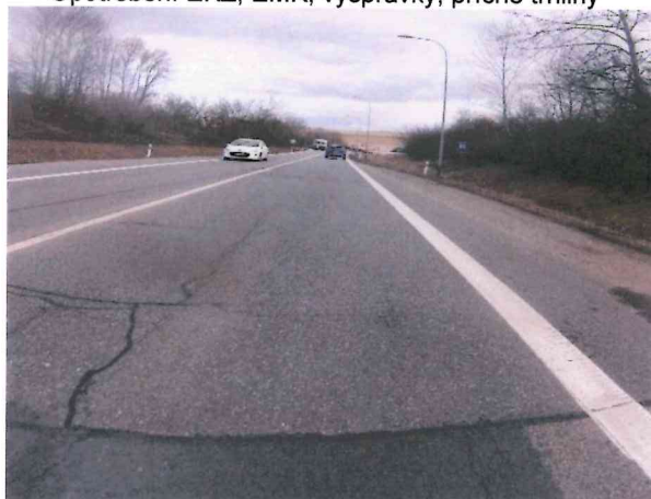
Hl. koroze, podélné a příčné trhliny, vysprávký
