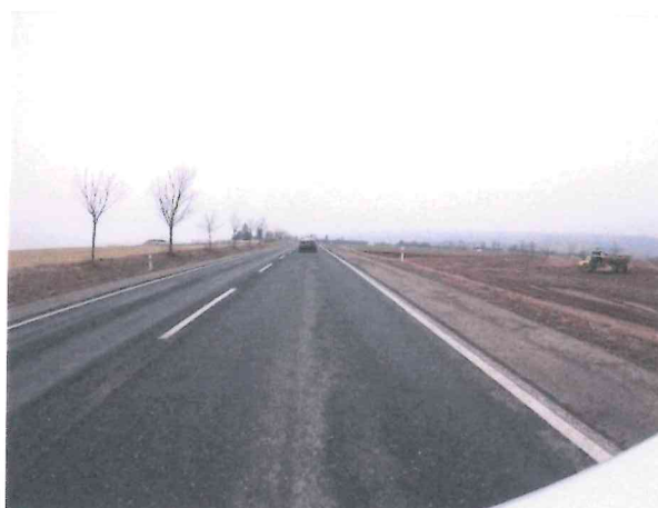
Hlubková koroze, vyjeté koleje deformace
