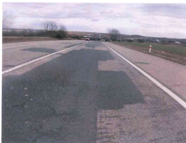
Opotřebení EKZ, EMK, vysprávký, příčné trhliny
