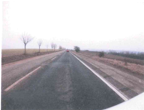
Hlubková koroze, vyjeté koleje
