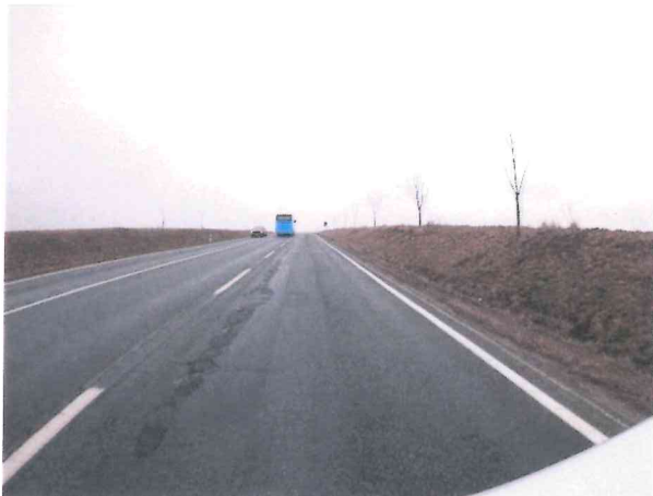
Hlubková koroze, podélné a příčné trhliny, vysprávk
