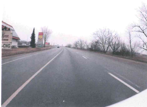
Ztráta makrotextury, vyjeté koleje
