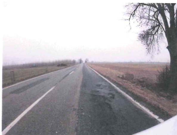
Hl. koroze, výtluky, podélné trhliny
