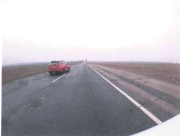
Ztráta makrotextury, příčné trhliny
