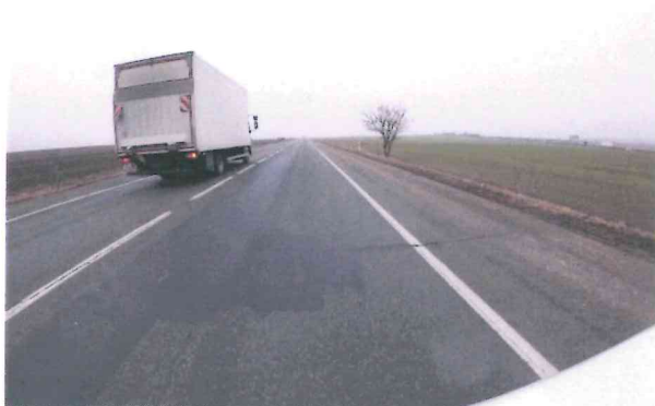
Ztráta makrotextury, pod. a příčné trhliny, vysprávk
